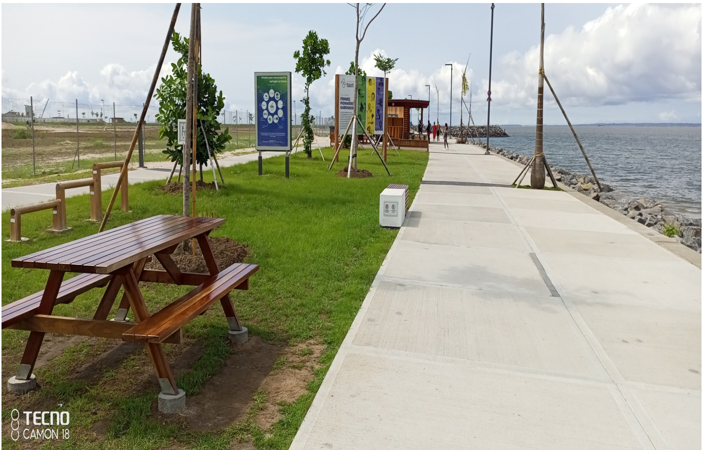
Photo : DGMP. Vue de la Promenade de la Zone 1 de la Baie des Rois à Libreville, Novembre 2022.
